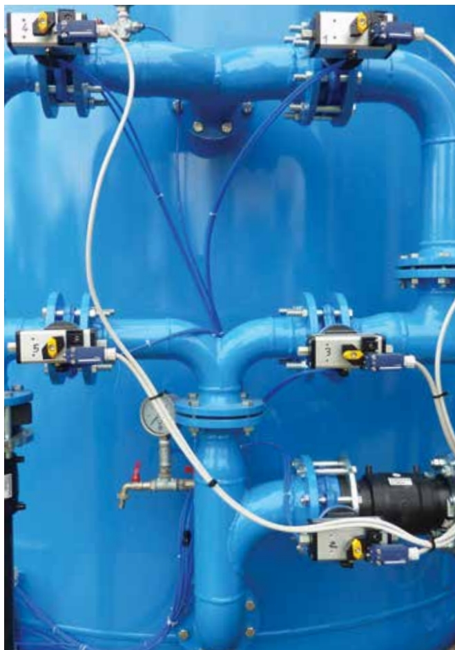
BATTERIA DI VALVOLE A FARFALLA CON ATTUATORE PNEUMATICO
