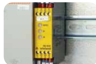
Relè di sicurezza a norma EN60204-1.
