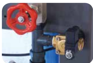
V. a spillo inox 316 + E.V. flussaggio
