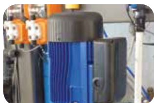
Pompa ad asse verticale inox.
