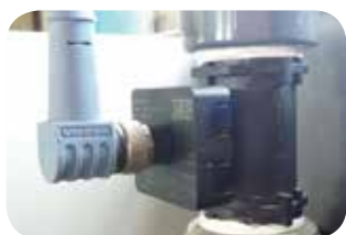
Trasd. portata electr. (opzionale).
