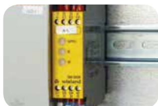
Relè di sicurezza a norma EN60204-1.
