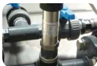
Trasd. pressione electr.(opzionale).
